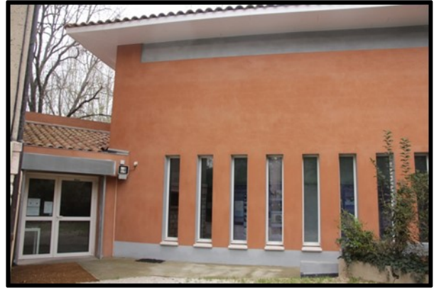
Bâtiment neuf : entrée du planétarium
