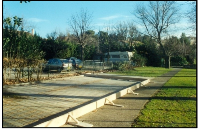
Coulage de la dalle 6 mars 2001
