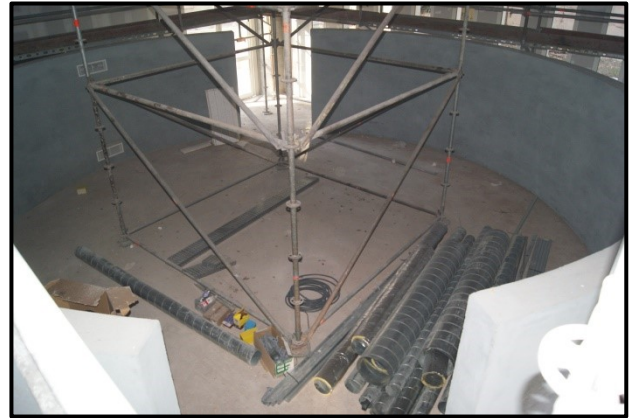
Mur de soutènement de la future coupole 13 mars 2012
