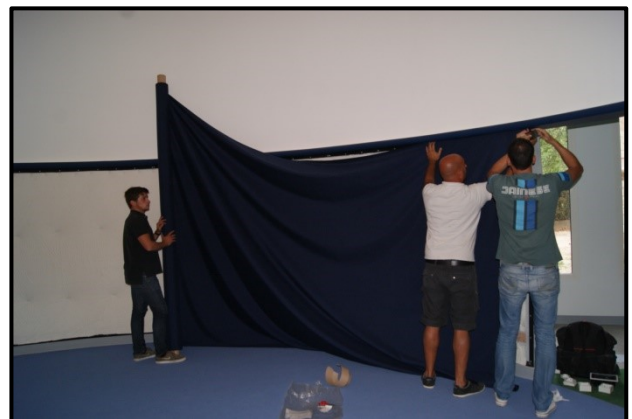
Pose du revêtement intérieur 23 septembre 2014
