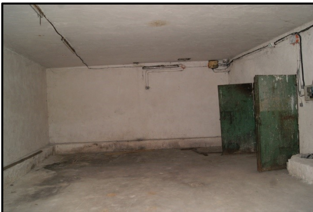
Sous-sol du hangar avant transformation 17 avril 2013
