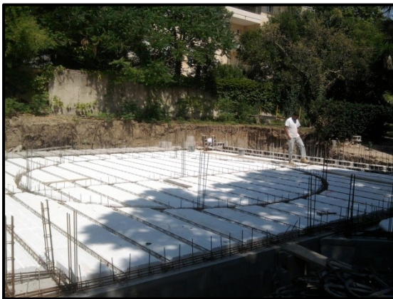
Mise en place des hourdis 3 août 2011
