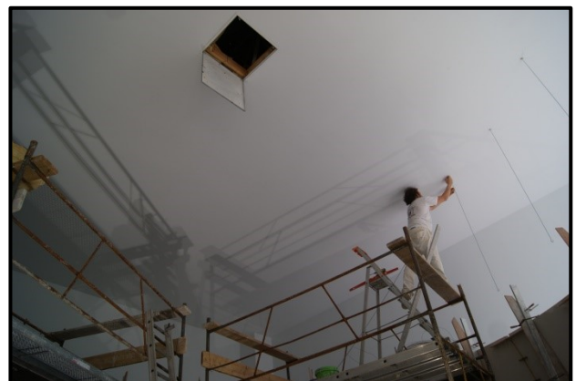
Pose des suspentes de la coupole 28 août 2014
