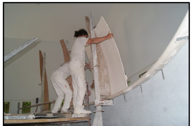
Pose du premier élément de coupole (staff) 27 août 2014
