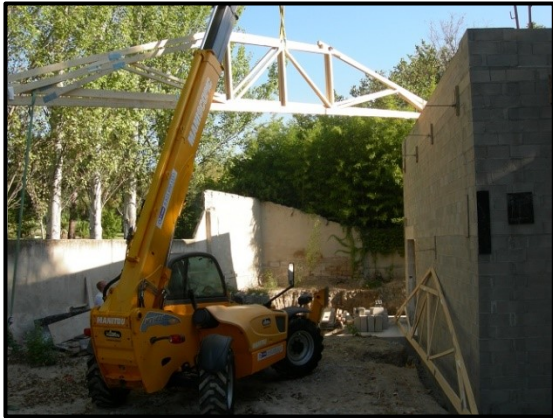
Mise en place des fermettes 3 octobre 2011
