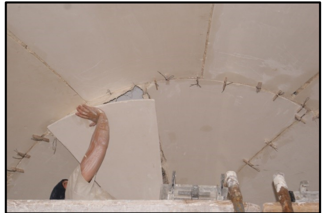
Pose du dernier pétale de la calotte 29 août 2014
