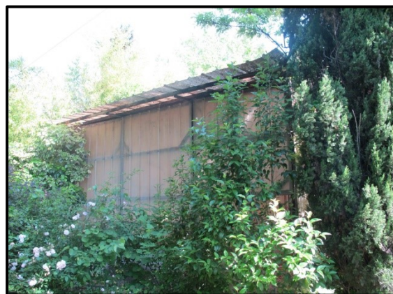
Ancien hangar désaffecté
