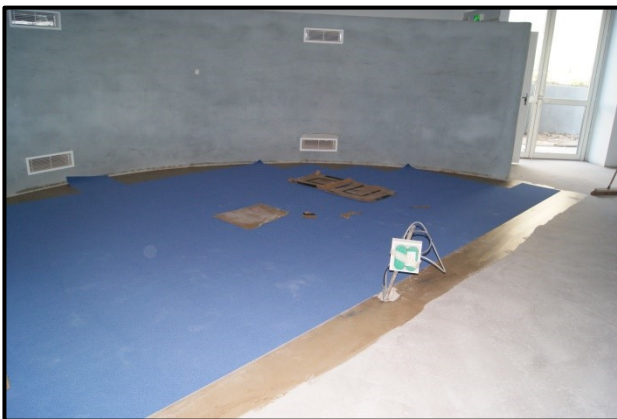
Pose de la moquette 18 décembre 2012
