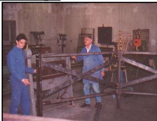
Construction du bâti métallique Octobre 1994
