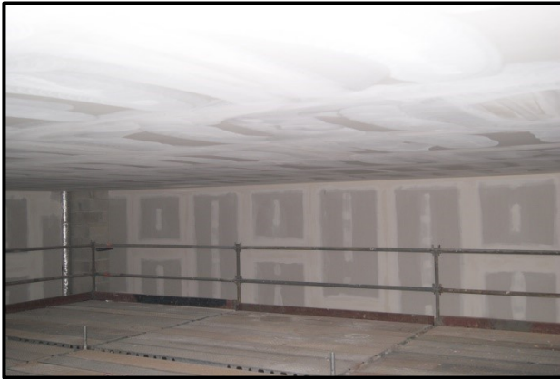
Faux plafond vu depuis un échafaudage 13 mars 2012
