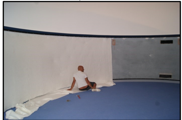
Pose de la couche matelassée pour insonorisation 23 septembre 2014
