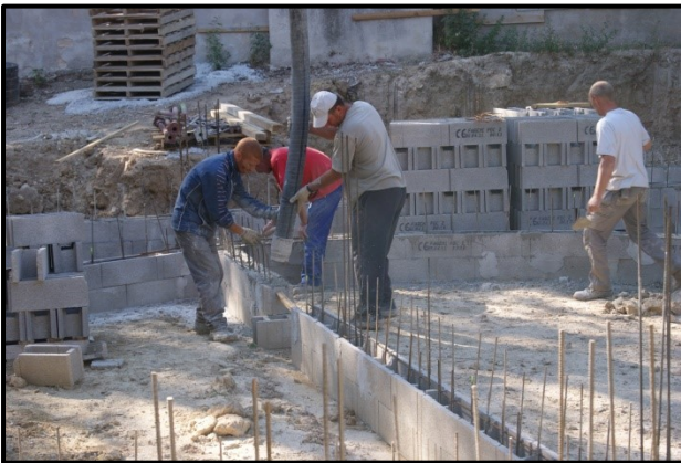
Maçons en pleine action 20 juillet 2011
