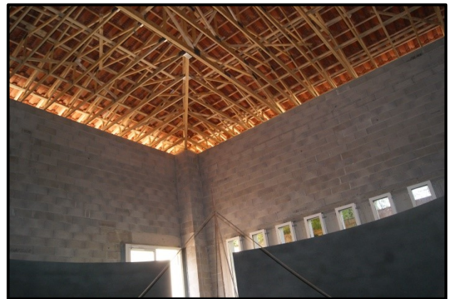
Toiture achevée 21 janvier 2012
