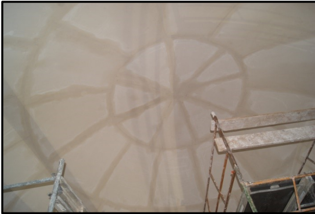
Coupole jointée, en voie de séchage 30 août 2014
