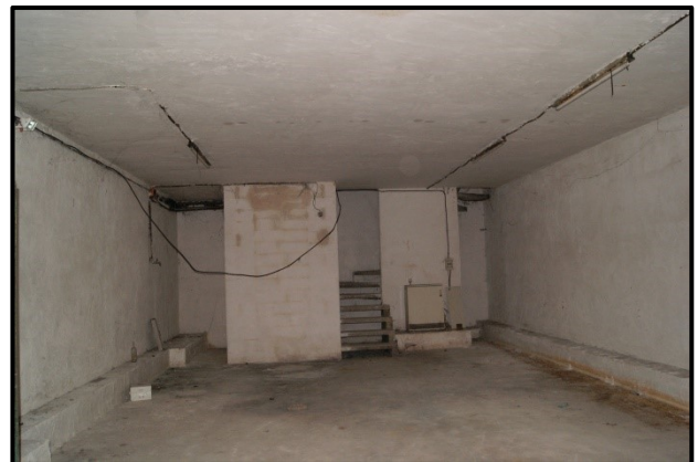
Sous-sol du hangar avant transformation 17 avril 2013
