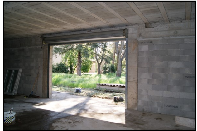
Intérieur avant travaux 17 avril 2013
