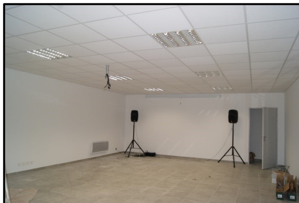
État du hangar rénové 19 juin 2013
