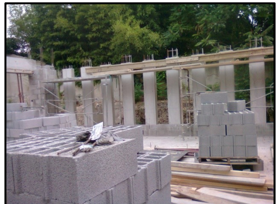
Murs décoffrés 3 septembre 2011
