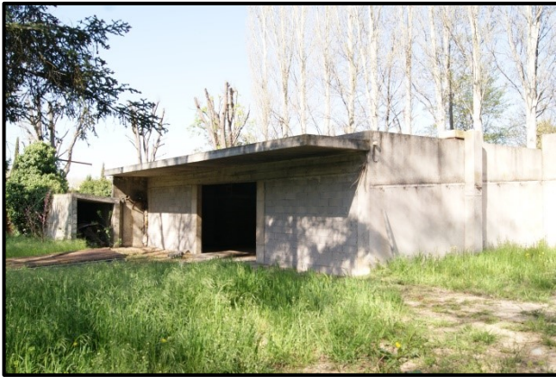
Extérieur avant travaux 17 avril 2013
