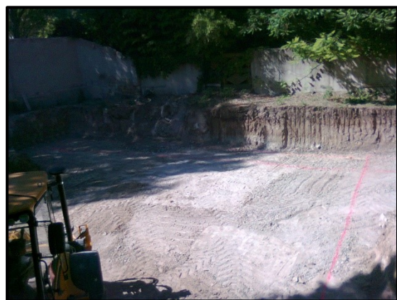
Marquages au sol et premières excavations 20 juin 2011
