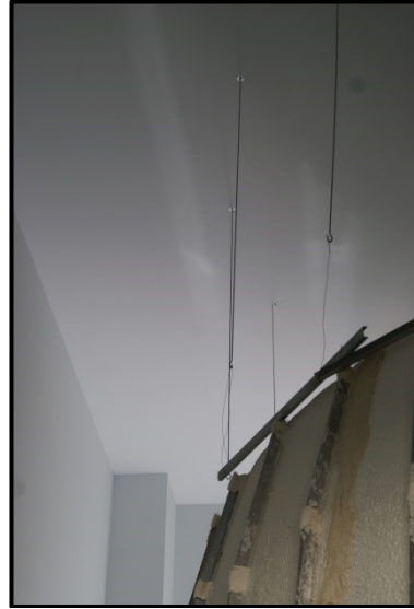
Armatures et suspentes assemblées 28 août 2014
