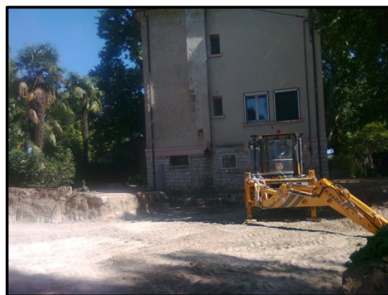
Pelle mécanique lors de l'excavation 20 juin 2011
