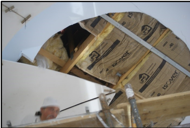
Découpe dans le faux plafond pour mettre en place la calotte 29 août 2014
