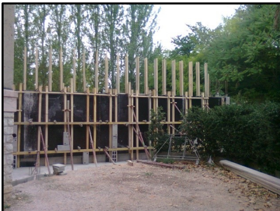
Coffrage des murs 3 septembre 2011
