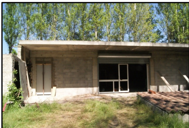
Mise en place des deux entrées 4 mai 2013
