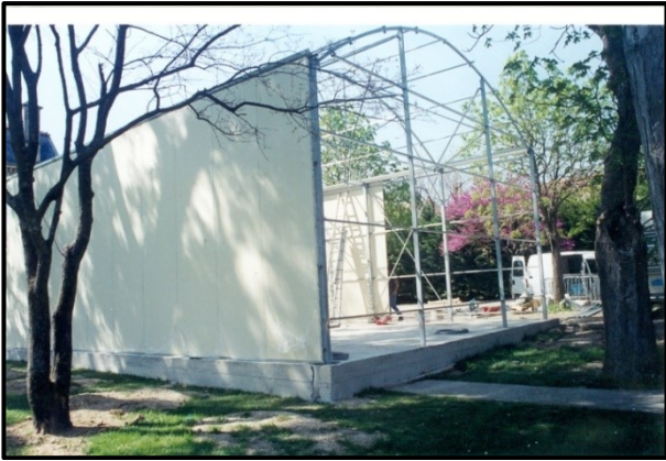
Mise en place de la serre Mars 2001
