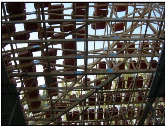
Paquets de tuiles déposées sur les fermettes 10 octobre 2011
