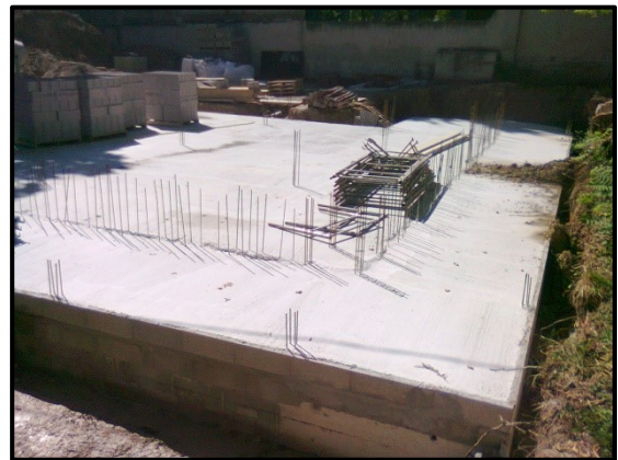
Coulage de la dalle 8 août 2011
