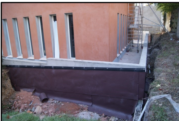
Étanchéité du muret extérieur 21 février 2012
