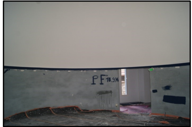
Coupole achevée (peinture) 16 septembre 2014
