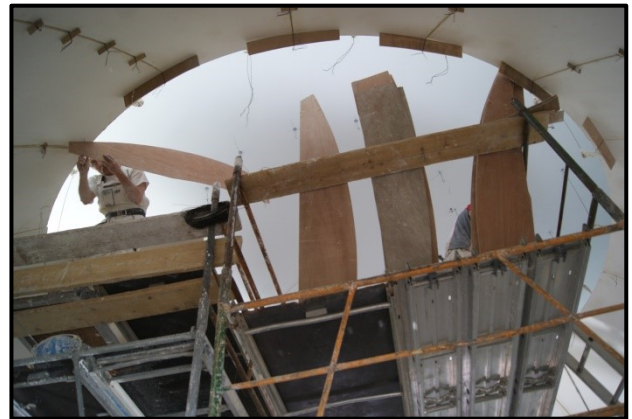
Gabarit pour troisième rang de plaques 29 août 2014
